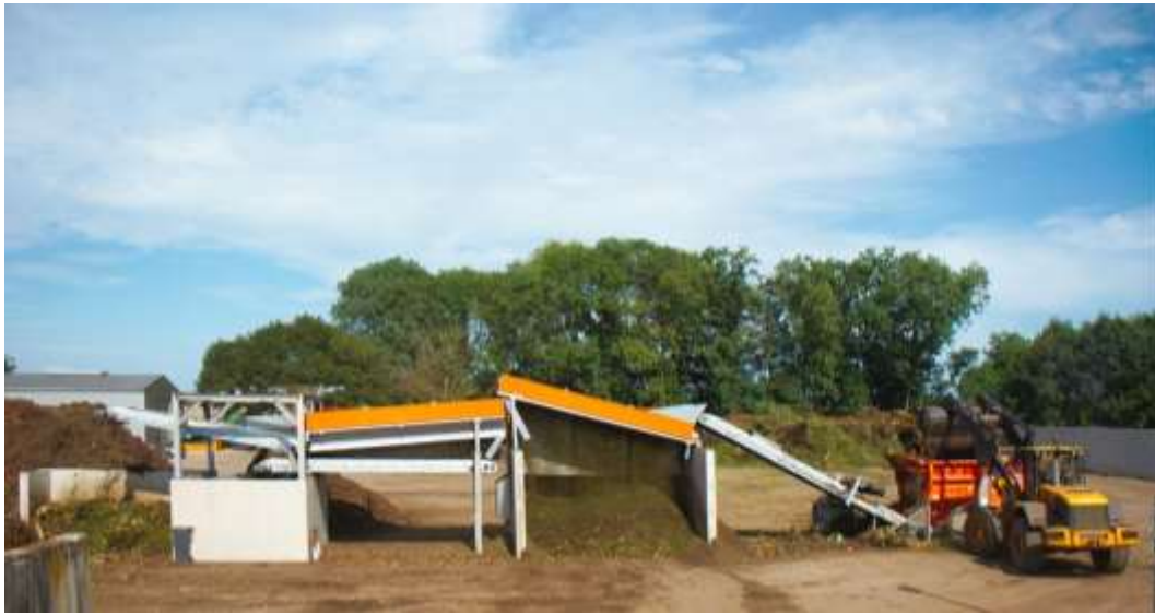
Installation de broyage-criblage (de droite à gauche : broyeur lent, convoyeur, crible 3 fractions)
