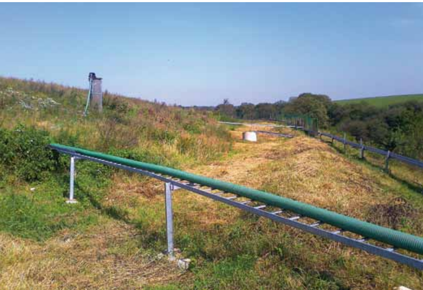
[ Bordure du dôme et puits de dégazage ]
