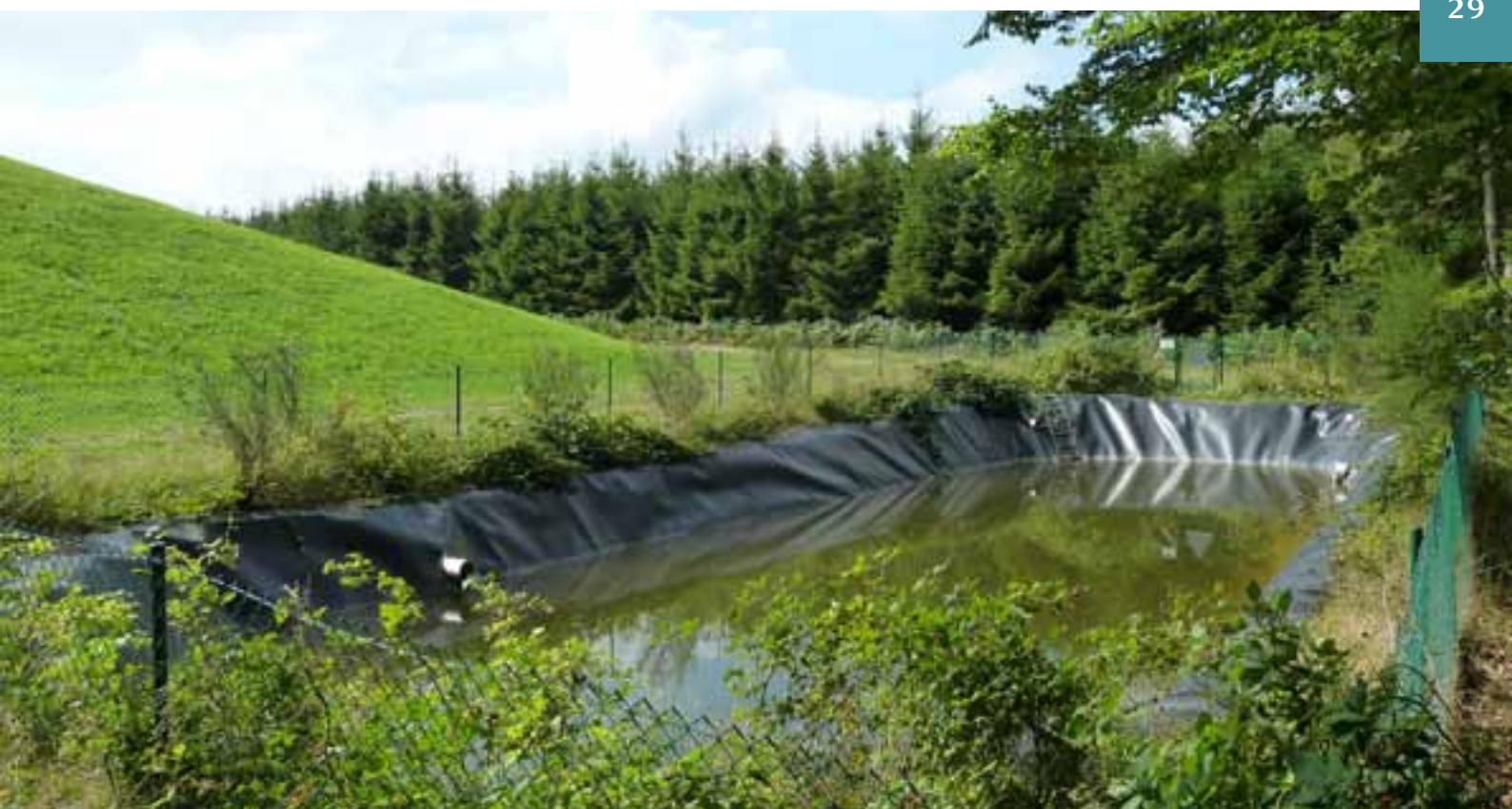
[ Bassin d'orage du CET de Malvoisin ]
