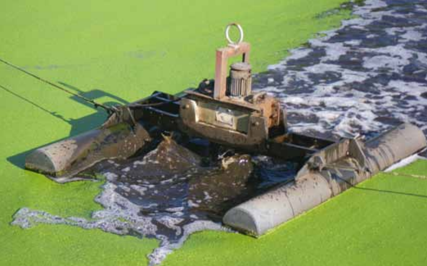
[ Aérateur de surface de la lagune de stockage des eaux de ruissellement ]
