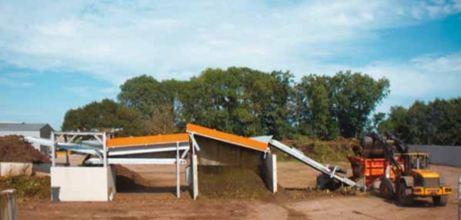
[ Installation de broyage-criblage (de droite à gauche : broyeur lent, convoyeur, crible 3 fractions) ]
