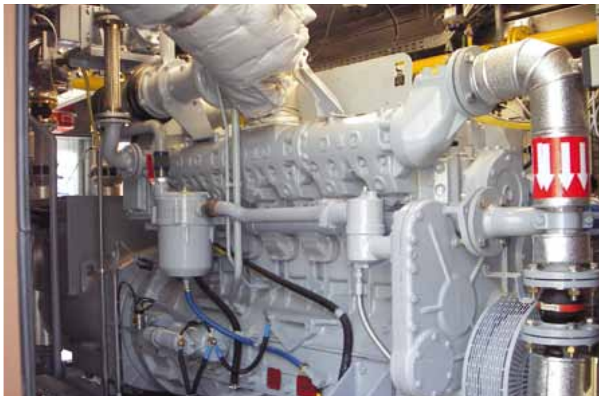
[ Cogénération : moteur à biogaz ]
