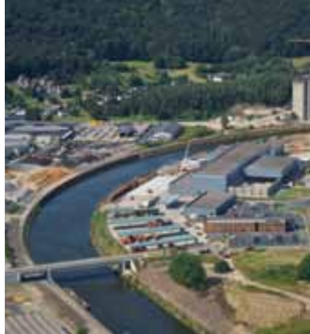
Site du BEP Environnement à Floreffe
