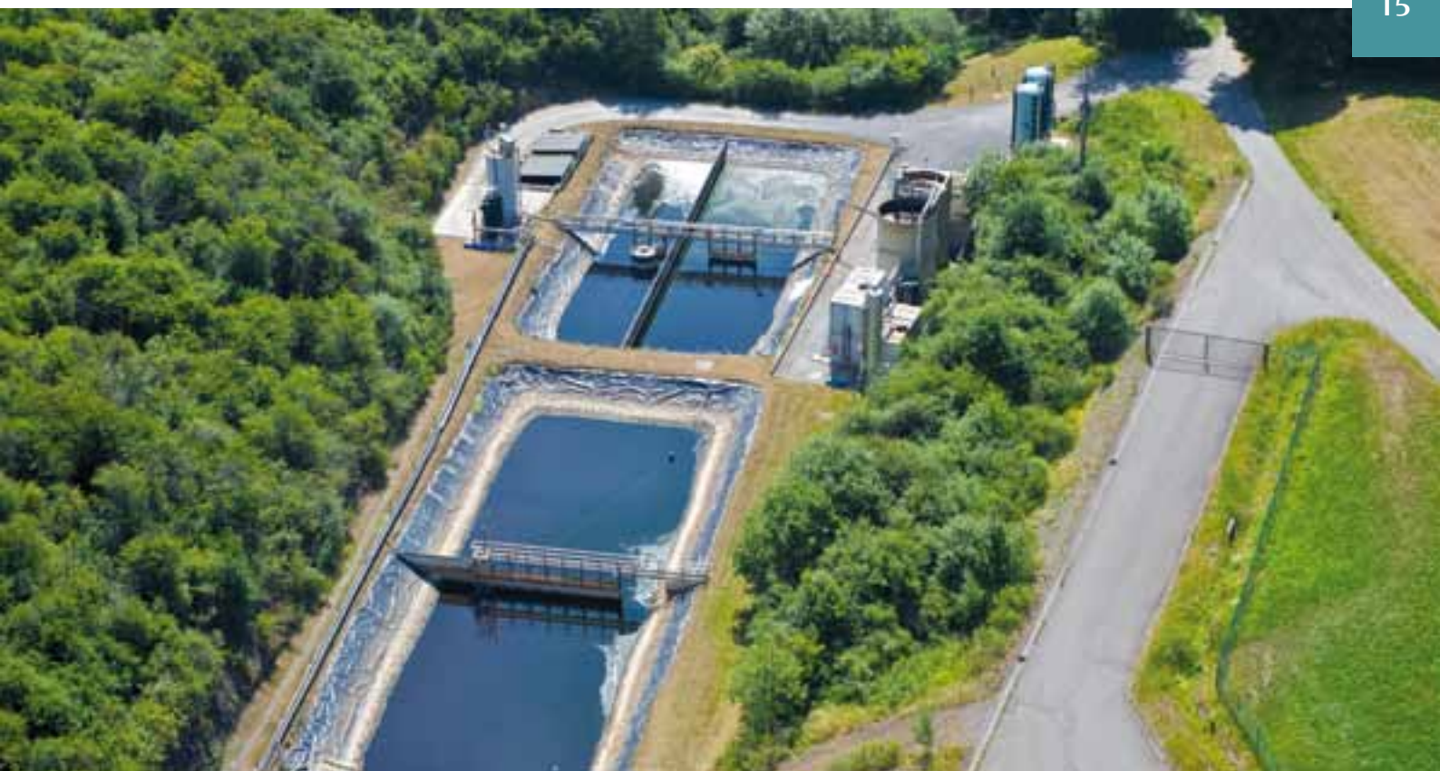
[ Station d'épuration du CET de Chapois ]
