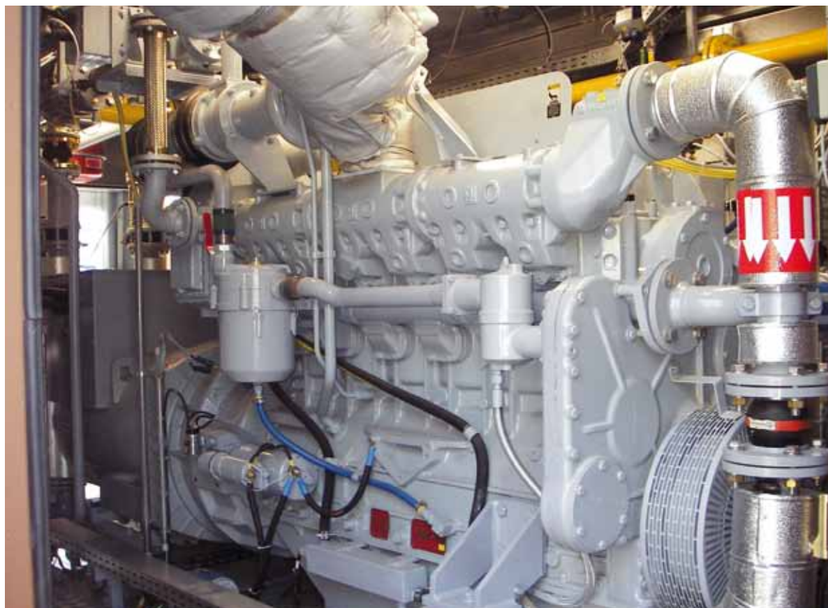
[ Cogénération : moteur à biogaz ]
