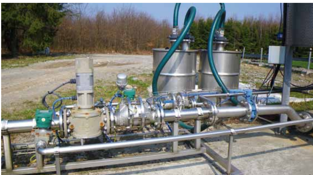
[ Équipements de gestion du biogaz arrivant à la torchère ]
