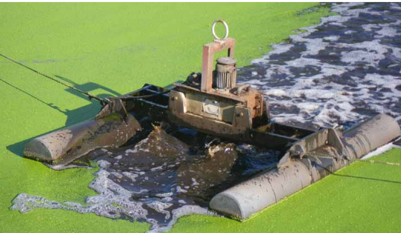
[ Aérateur de surface de la lagune de stockage des eaux de ruissellement ]
