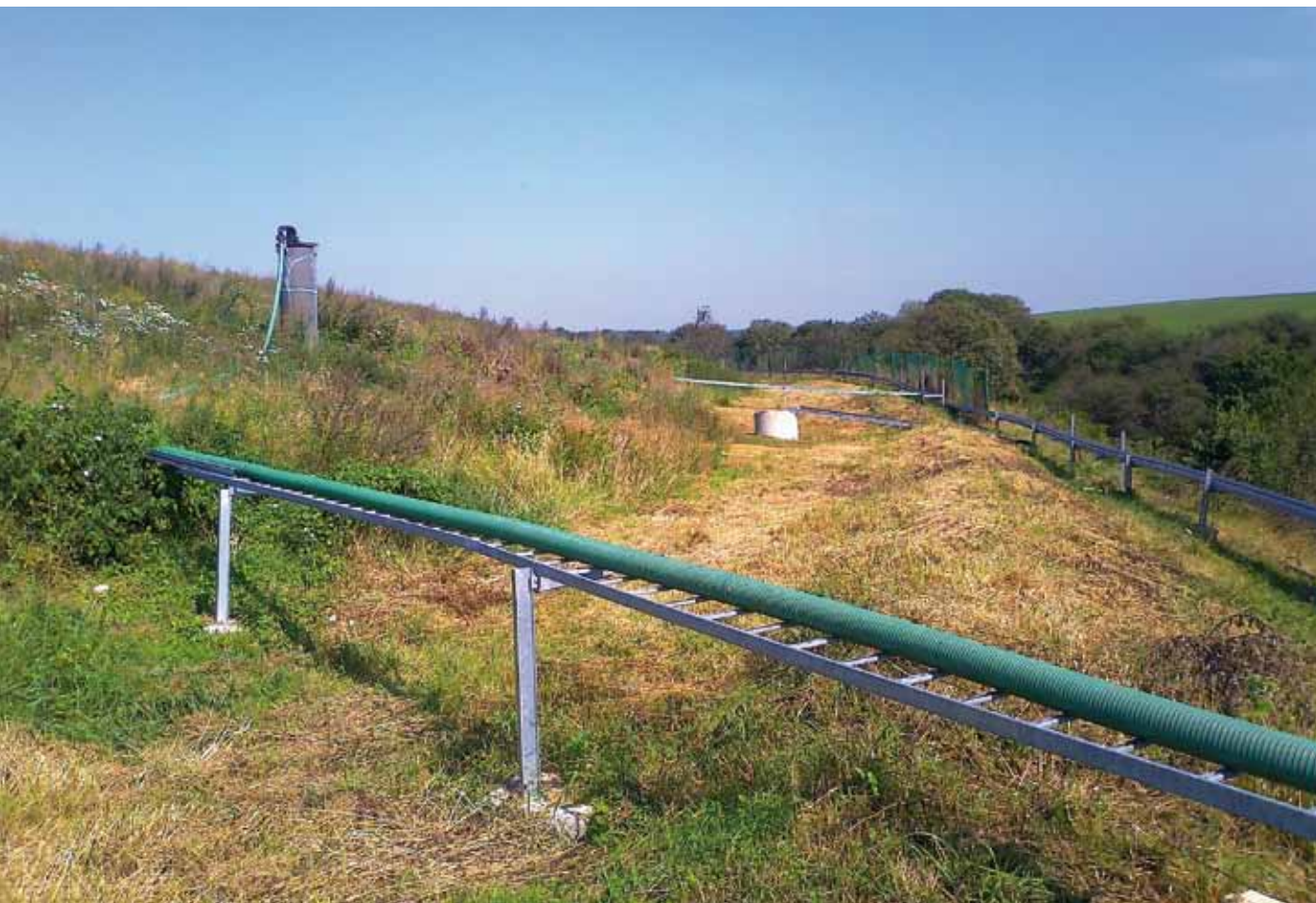
[ Bordure du dôme et puits de dégazage ]
