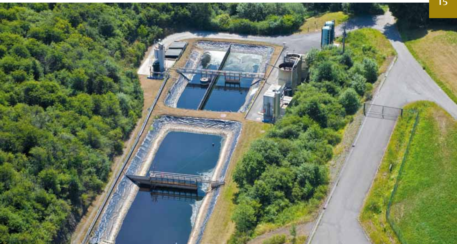
[ Station d'épuration du CET de Chapois ]
