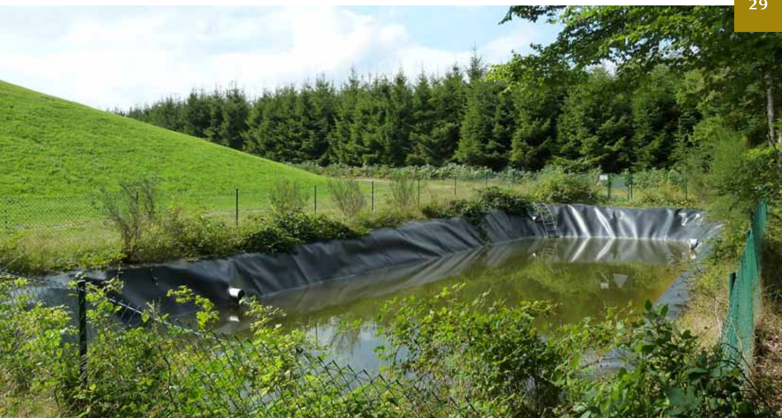
[ Bassin d'orage du CET de Malvoisin ]
